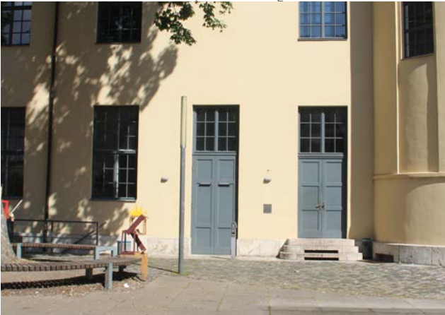
Geschwister-Scholl-Straße 8, barrierefreier Zugang Südfassade
