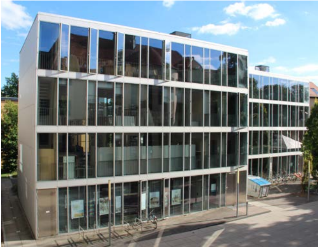
Belvederer Allee 1 a/b, Nordfassade
